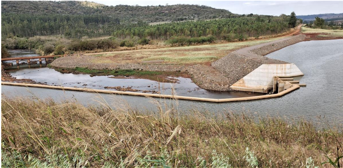
Figura 01: O barramento da CGH OURO BRANCO e início do TVR – trecho de vazão reduzida
