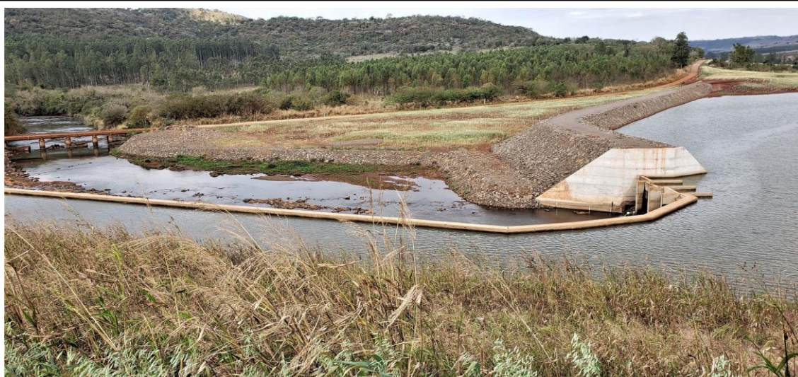
Figura 04: Canal de aproximação à adução, com vertedor na crista
