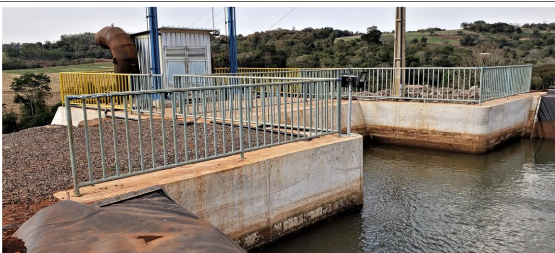
Figura 09: Adução para a Câmara de Carga
