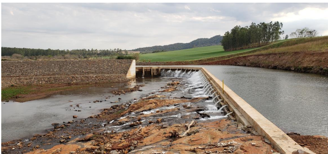
Figura 07: Canal de aproximação, vertedor, dutos da vazão ecológica e início do TVR
