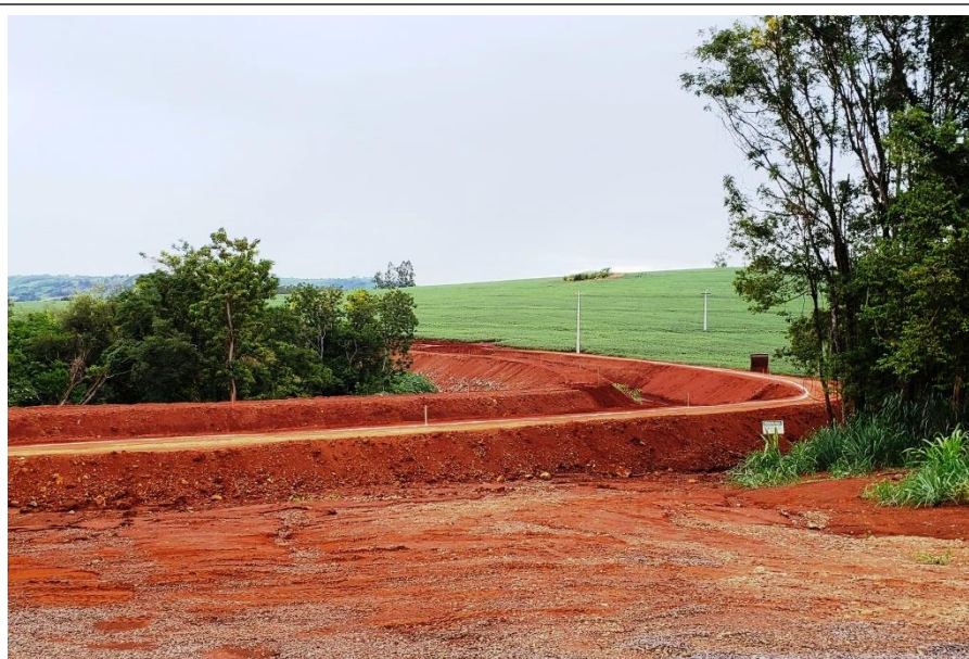
Figura 11: trecho do Canal Adutor em obra, em local que corta a APP de afluente.
