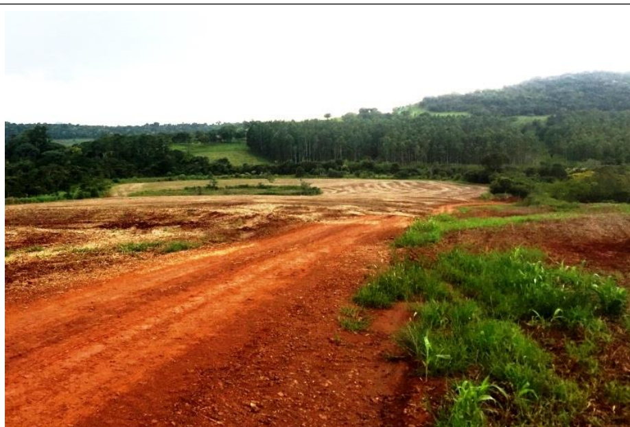
Figura 5: Lombadões em estrada de acesso à Obra, para prevenir erosão rural
