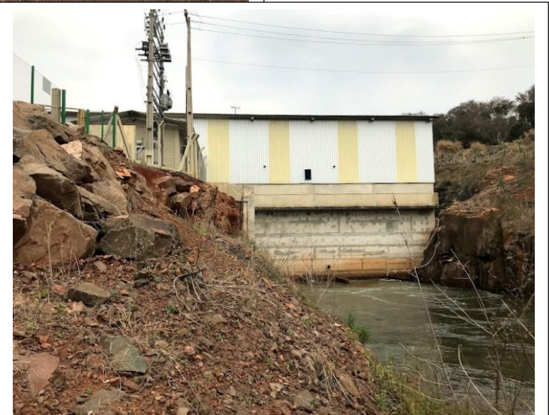
Figura 05: Jusante da Casa de força: canal de restituição
