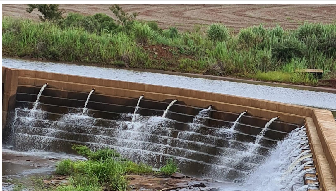
Figura 05: Dutos implantados na estrutura do barramento garante a vazão sanitária permanente.
