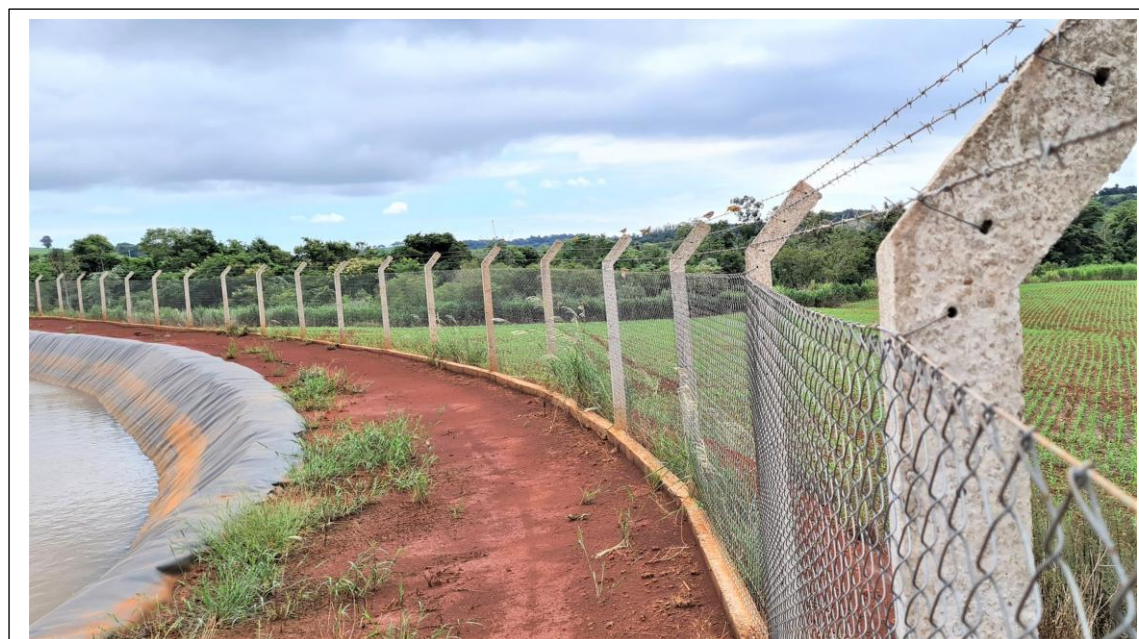
Figura 11: Cercas de proteção do canal de adução. A. Muller 15. Mar. 2022.
