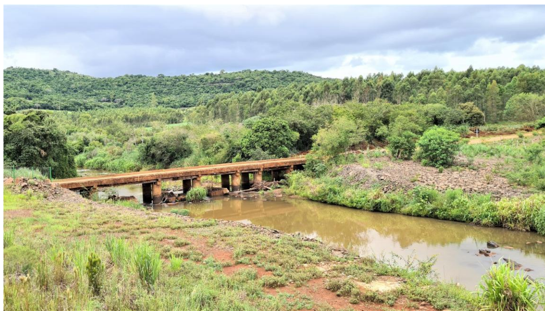
Figura 12: Ponte sobre a estrada de Peabiru: Início do TVR da CGH Ouro Branco. A. Muller 15. Mar. 2022.
