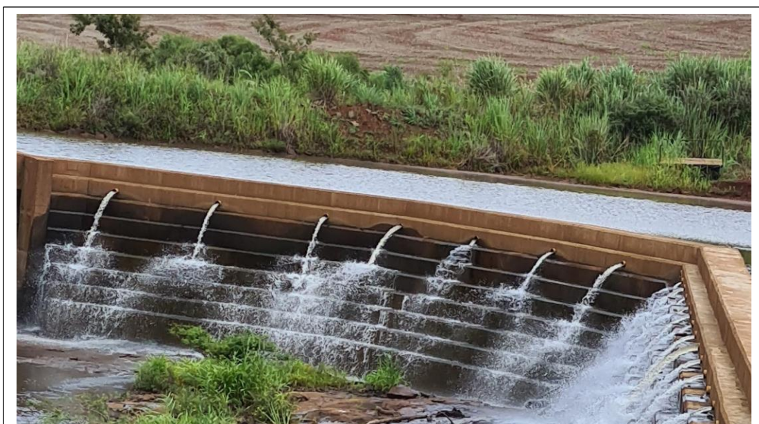
Figura 07: A vazão sanitária ou ecológica flui livre por dutos situados no vertedouro A. MULLER, 15. mar. 2022.
