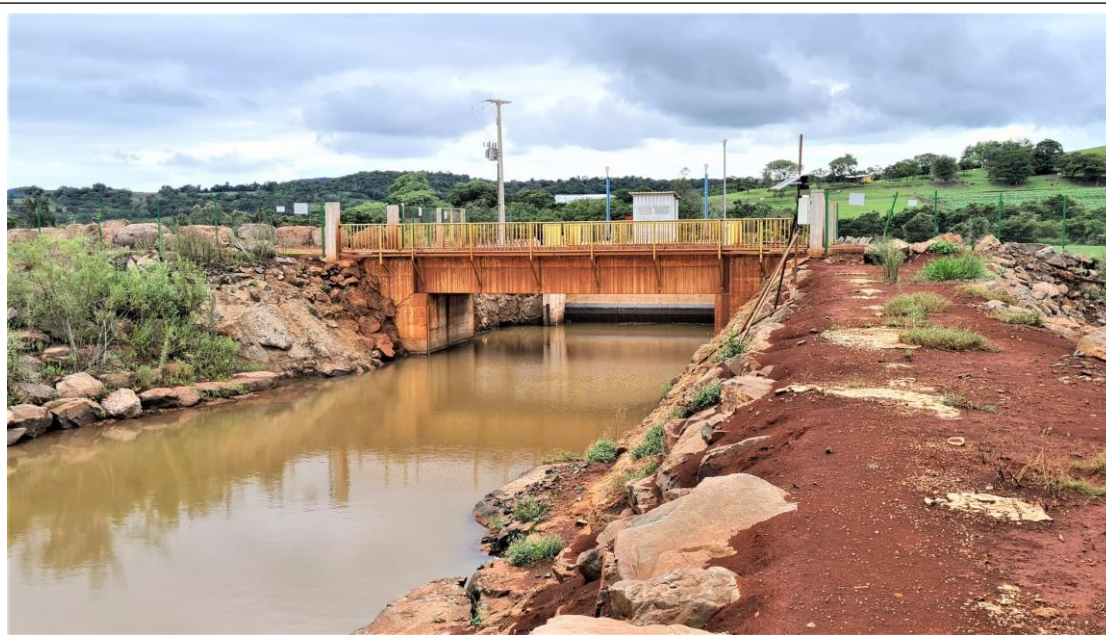
Figura 13: Início do canal de adução, com dispositivo de controle da vazão. A. Muller 15. Mar. 2022.
