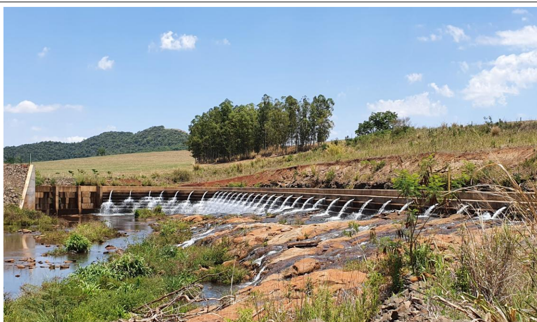
Figura 10: Vazão sanitária ou ecológica por 32 tubos de 150mm, no vertedouro da CGH Beira Rio. A.MULLER, em 18.08.2023
