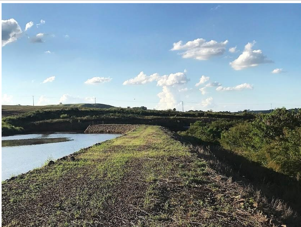
Figura 12: Base superior do dique do barramento da CGH OURO BRANCO luri Bayerl em 28.mar.2023
