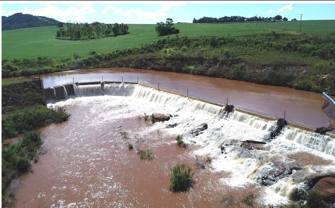
Figura 17: Vazão sanitária ou ecológica por 32 tubos de 150mm, no vertedouro da CGH Beira Rio. Iuri Bayerl, em 12.12.2023
