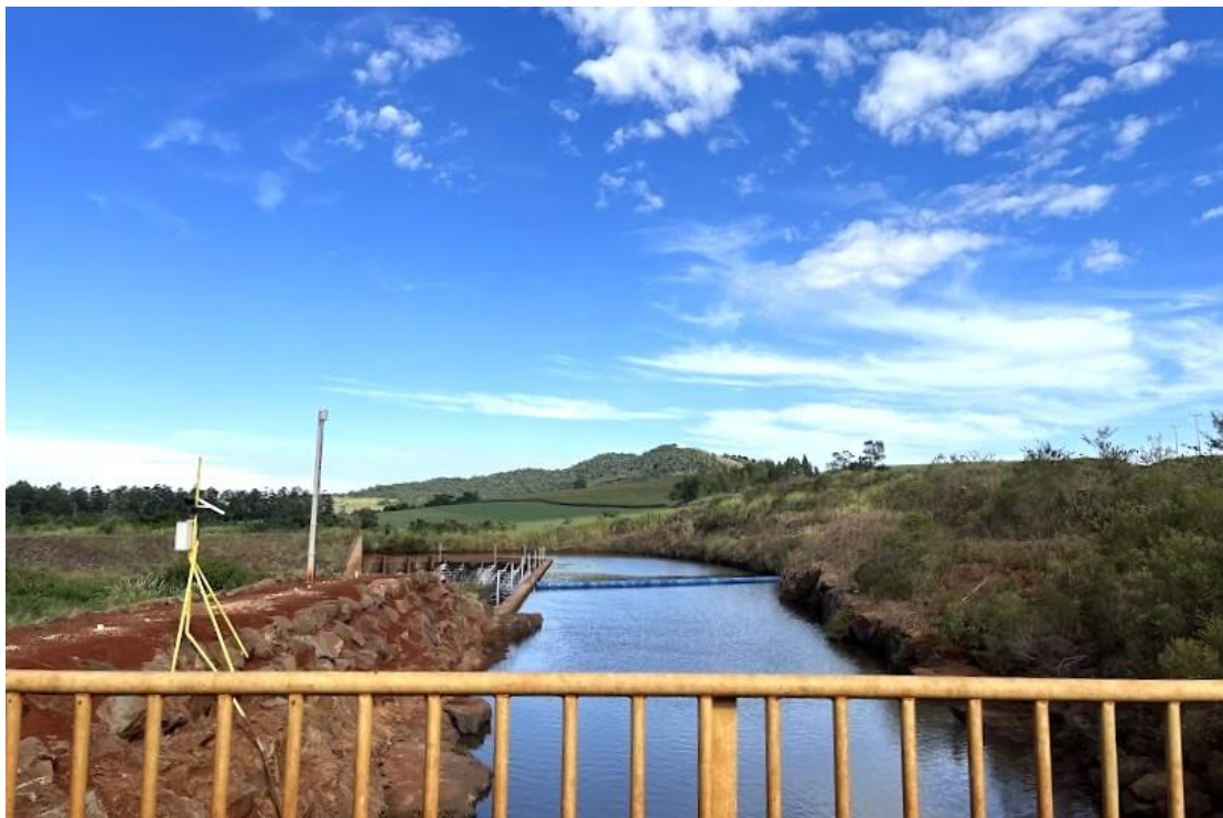
Figura 20: Logboom limitando resíduos no acesso do Canal de aproximação da CGH OURO BRANCO. Iuri Bayerl em 02 de maio de 2024.
