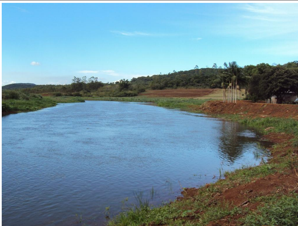
Figura 5 Reservatório da CGH Ouro Branco durante o processo de alagamento, exibindo a faixa marginal que foi previamente desmatada.
