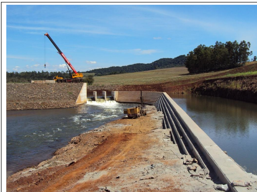
Figura 2 Eixo de barramento da CGH Ouro Branco, em preparação para iniciar os procedimentos de alagamento.
