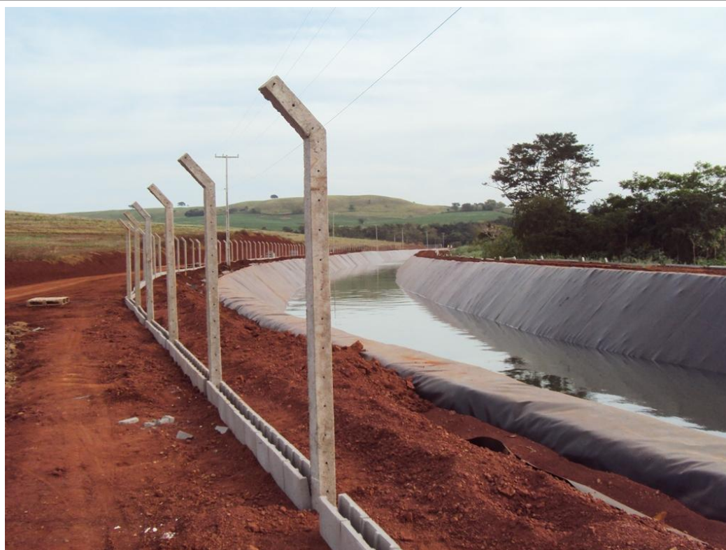
Figura 4 Estrutura da cerca do canal de adução em construção, exibindo a possibilidade de acidentes com queda de animais no escoadouro até a conclusão do cercamento.
