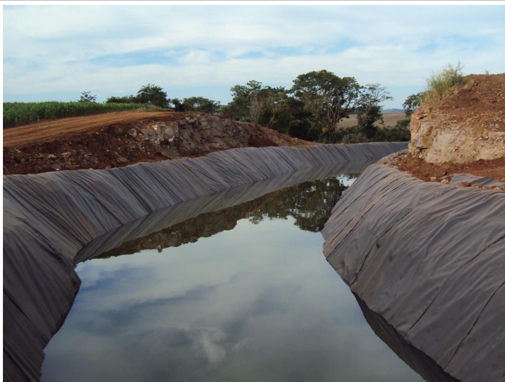
Figura 12 Inspeção do canal de adução no segundo dia de operação, preenchido com água. A ausência de cercamento ainda é verificada em grande parte do escoadouro.
